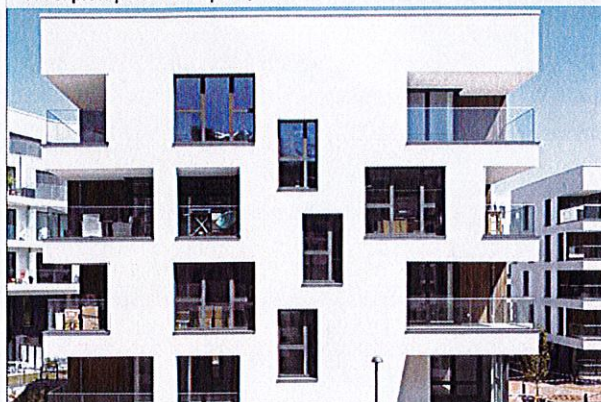
sursa: PETITDIDIERPRIoux Architects
