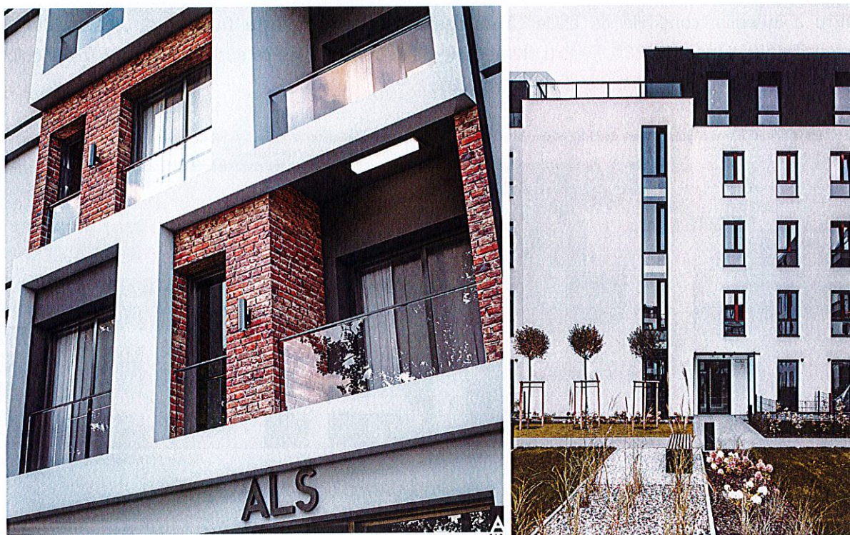
Exemplu tratare fațadă - finisaje, Sursa: https://mazm.pl/nova-atmosfera , https://alsmimarlik.com/
